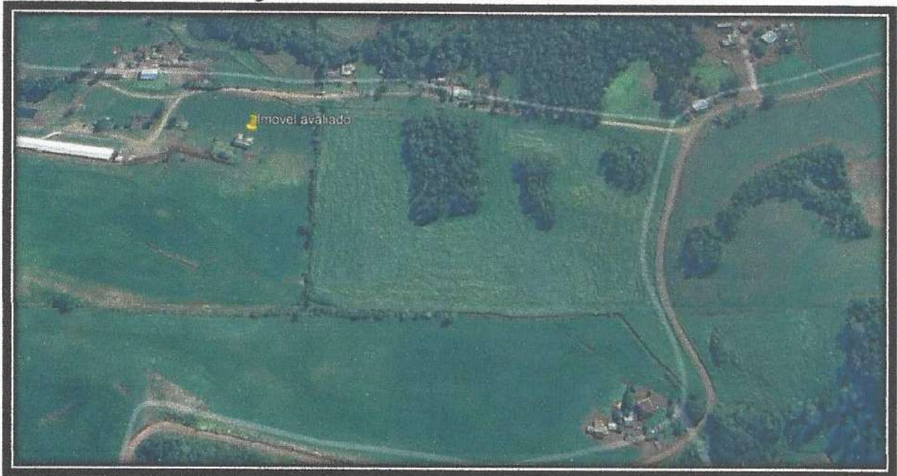
Figura 01 - Foto aérea do imóvel avaliado.
