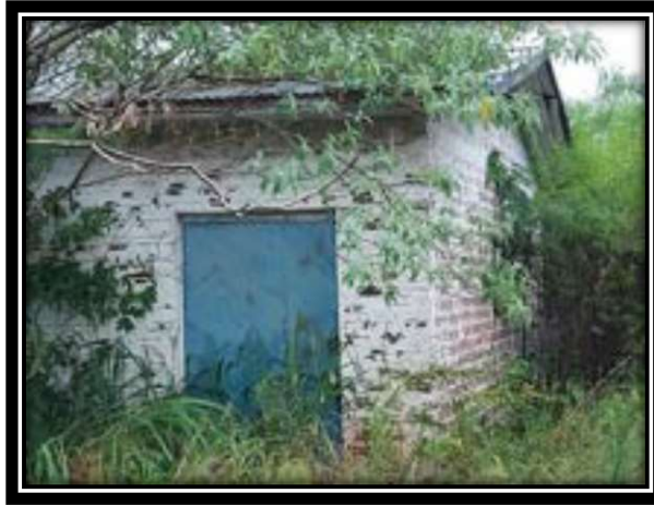
Foto 39 - Edificação de fundos.
