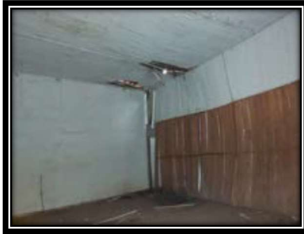
Foto 36 - Dependências internas da edificação frontal.
