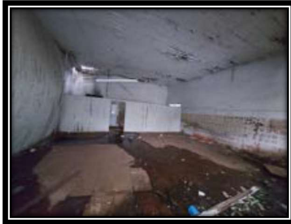
Foto 37 - Dependências internas da edificação frontal.
