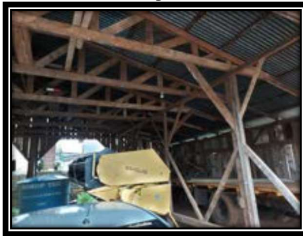
Foto 28 - Garagem de fundos.
