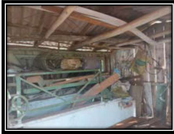
Foto 146 - Depósito de entulho.
