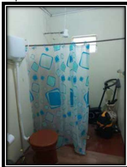
Foto 113 - Dependências internas da residência II.
