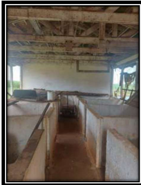
Foto 149 - Edificação da UTI.
