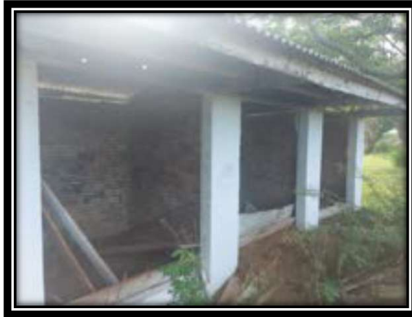
Foto 151 - Edificação da composteira.
