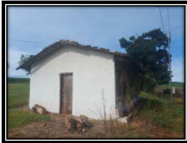
Foto 147 - Edificação da UTI.
