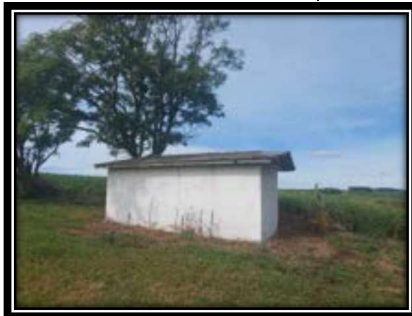
Foto 150 - Edificação da composteira.
