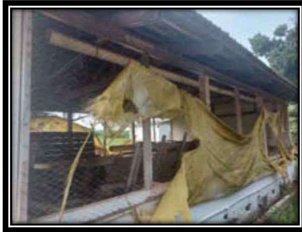
Foto 148 - Edificação da UTI.
