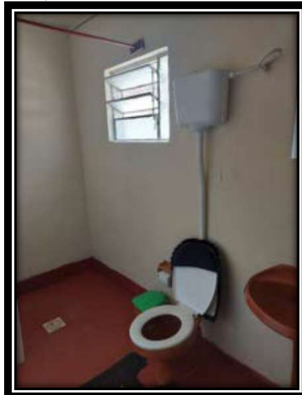
Foto 104 - Dependências internas da residência I.
